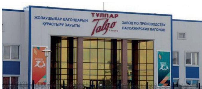
Вагоноремонтный завод «Тулпар-Тальго», г. Нур-Султан
