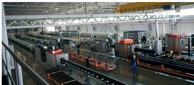
Завод полиэтиленовых труб Шеврон-Мунайгаз
