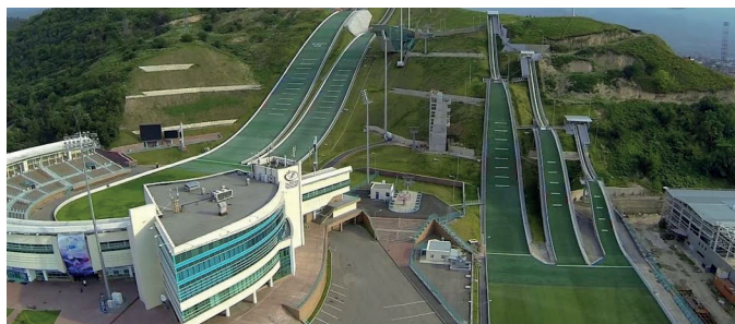
Комплекс горнолыжных трамплинов, г. Алматы
